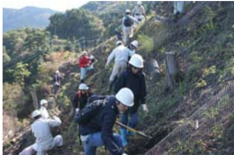
植樹前に急斜面に直径約30cm深さ50cmの穴掘り
