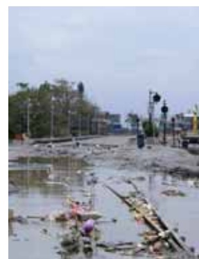
台風による被害状況
