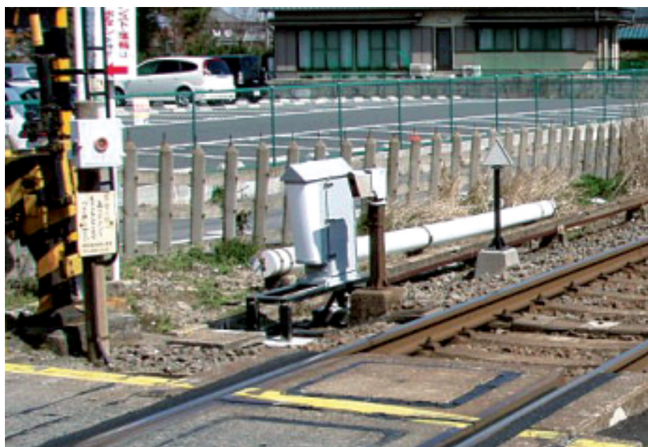
ミリ波式踏切障害物検知装置(設置例)
